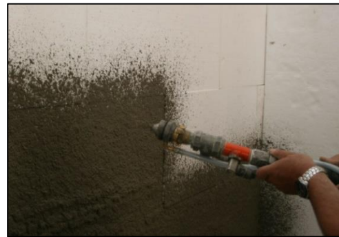
Obrázek 15 Nanášení stěrkové hmoty
