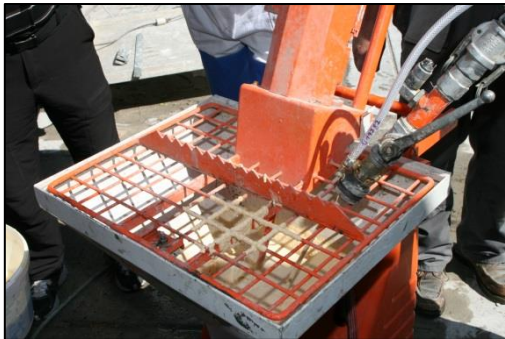
Obrázek 10 Nastavení tlaku vzduchu a výkonu čerpadla
