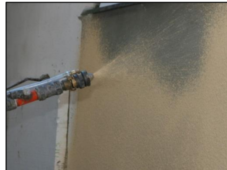
Obrázek 11 Stříkání omítky strojem PFT RITMO
