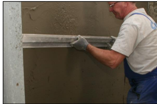
Obrázek 17 Finální zarovnání stěrkové vrstvy
