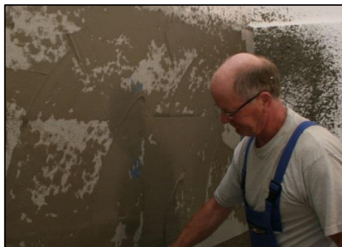
Obrázek 16 Zapracování síťoviny do stěrky
